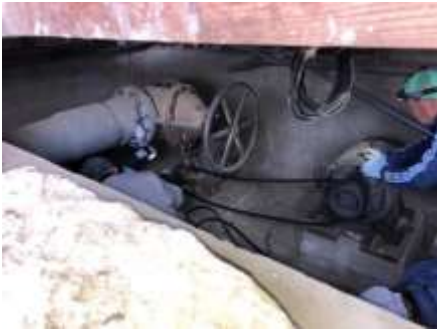
(揚水機<ポンプ設備>の点検)
